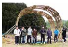
竹を活用した堆肥小屋 (田川市)
